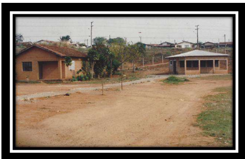
Endereço atual da Fesb. À esquerda, casa de caseiro e à direita, construção da primeira cantina no campus. Detalhe do terreno ainda sem pavimentação. 1994. Arquivo Permanente da Fesb.
