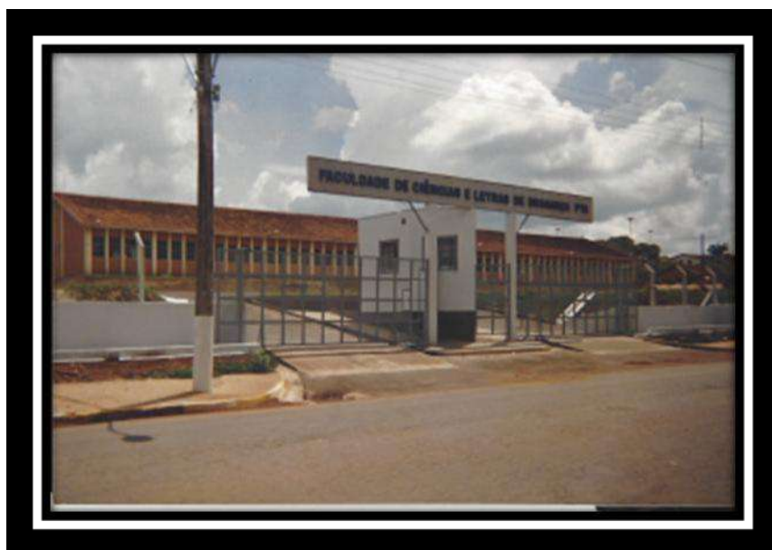
Endereço atual da Fesb. Destaque à primeira guarita de entrada do prédio já com pavimentação no terreno à frente. 1993-95. Arquivo Permanente da Fesb.
