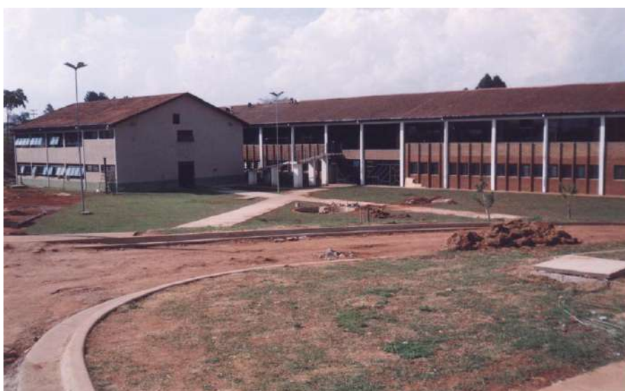
Dependências da Instituição. Vista laterla e frontal do prédio III. Atual Biblioteca. 1999
